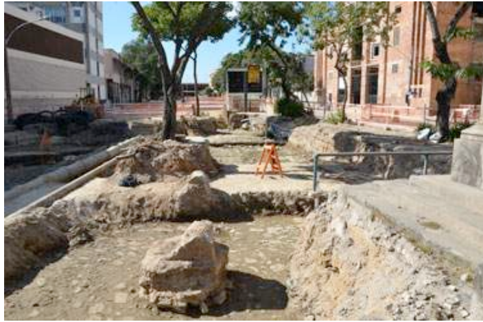
Travaux de voirie et fouilles archéologiques sur le site du Valongo (avril 2012)
