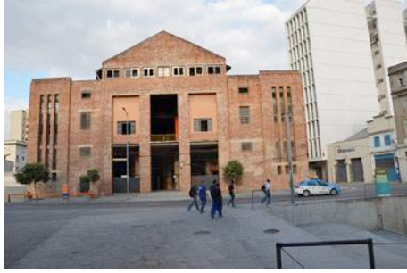
Le grand hangar des docks de Pedro II, probable futur musée/centre de mémoire du Valongo (2015)
